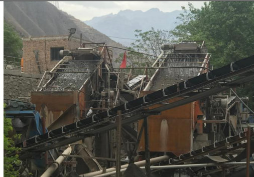
工艺粉尘（喷淋抑尘）
